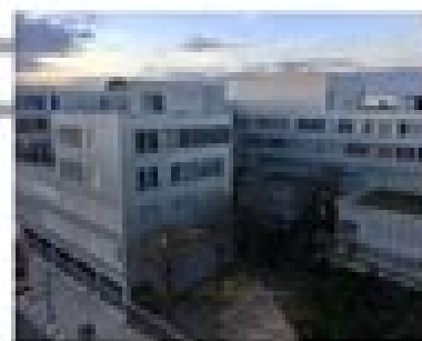
Climatisation des locaux raccordés au réseau
